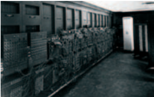
Technologie-Wunder 1946: Der ENIAC wog 30 Tonnen und arbeitete mit 17.468 Elektronenröhren.
